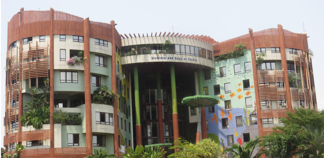
Façade du Ministère des Eaux et Forêts - Libreville (Gabon)
